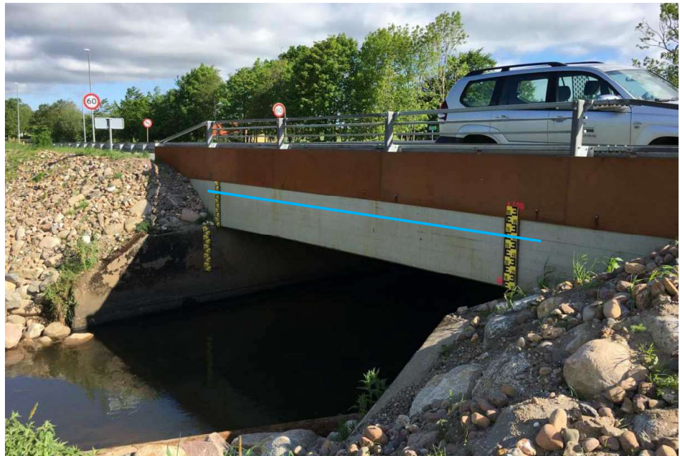
Figur 4.3: Beregnet maksimal vandstand ved Skagensvejsbroen over Elling Å for referencescenariet.
