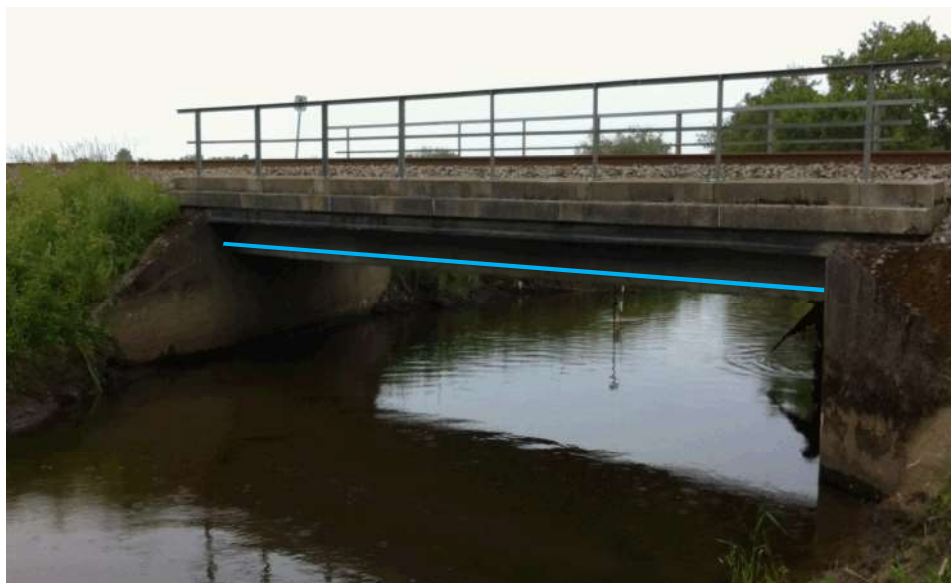
Figur 4.5: Beregnet maksimal vandstand ved Jernbanebroen over Elling Å for reference-scenariet.
